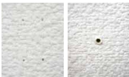
● ピン穴とネジ穴跡の比較 (写真左) ピン穴跡: \Phi 1ミリ程度 (写真右) ネジ穴跡: \Phi 3ミリ程度
